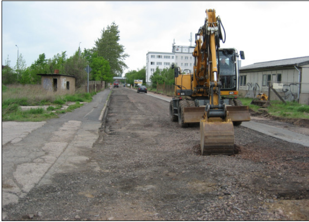
Gleichenstraße während Sanierung
