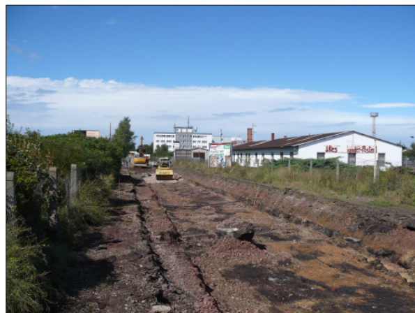
Verdichtung von Deponiebereichen mit Polygonzugwalze
