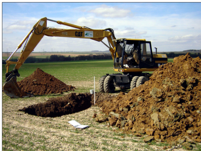
Bauabschnitt VKE 5522, Schurferkundung bei Wenigenlupnitz
