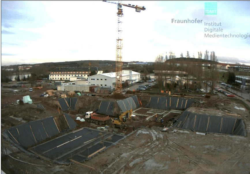
Blick auf die Baugrube im Dezember 2006
