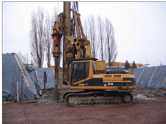
Herstellen von Gründungspfählen in der Baugrube
