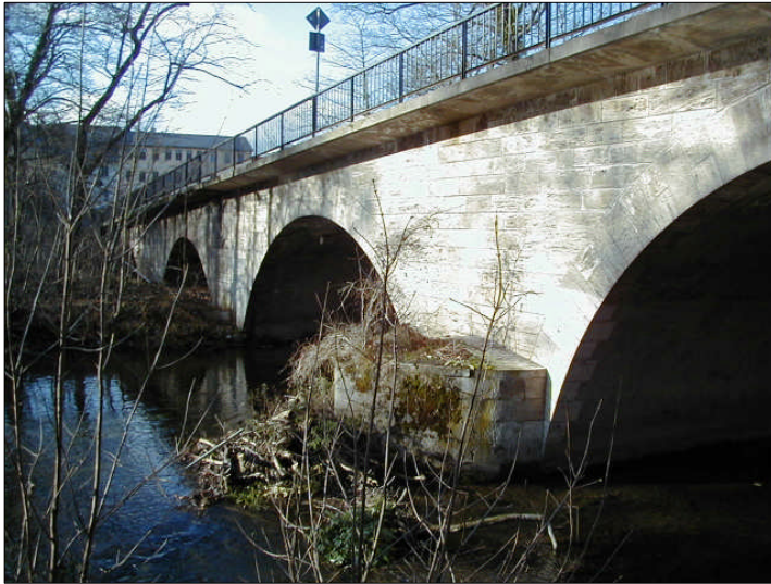
Südansicht der Kegelbrücke
