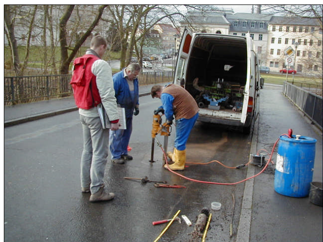
Kernbohrungen zur Erkundung des Straßenaufbaus & der Pfeilverfüllungen
