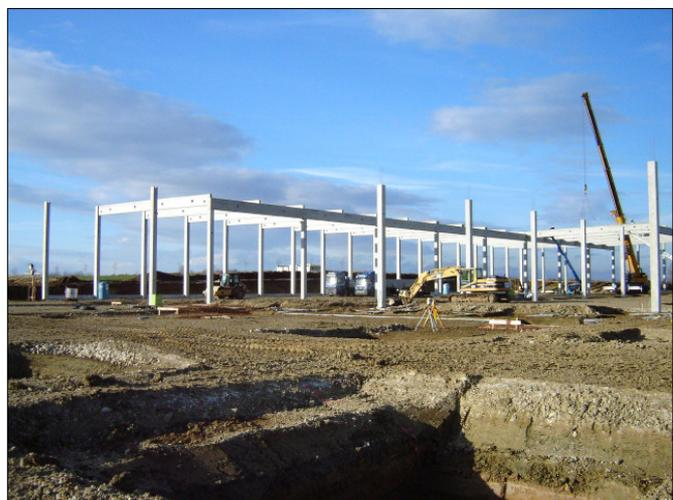
Baustelle, Errichtung der ersten Stützen sowie Gründungsarbeiten im Vordergrund
